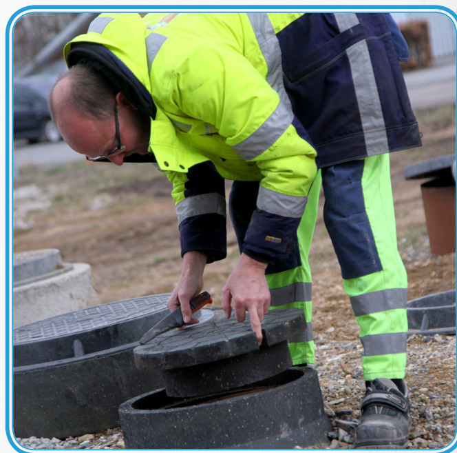
Verner H. Kristiansen kontrollerer kloakken
